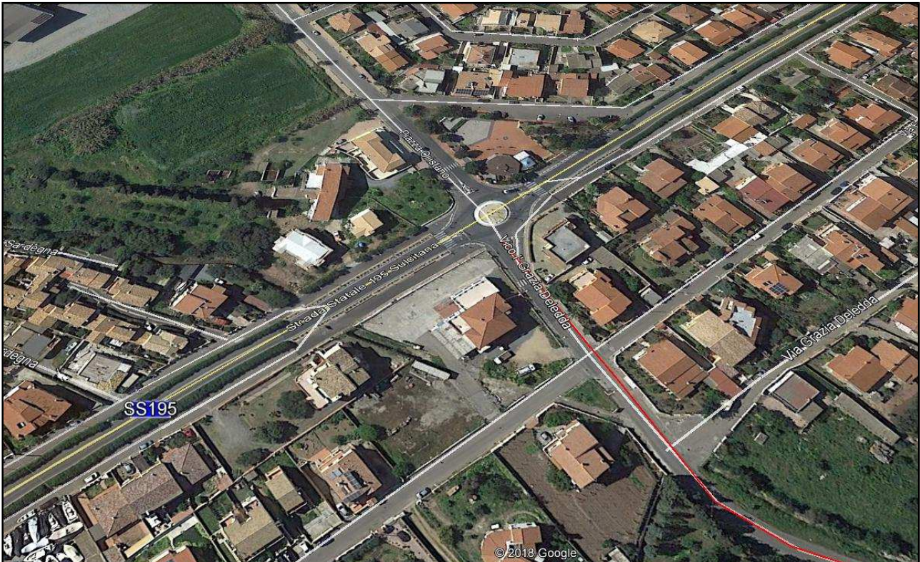
Immagine 2: Intersezione della Via Grazia Deledda con la SS 195 in prossimità della rotonda di innesto .
